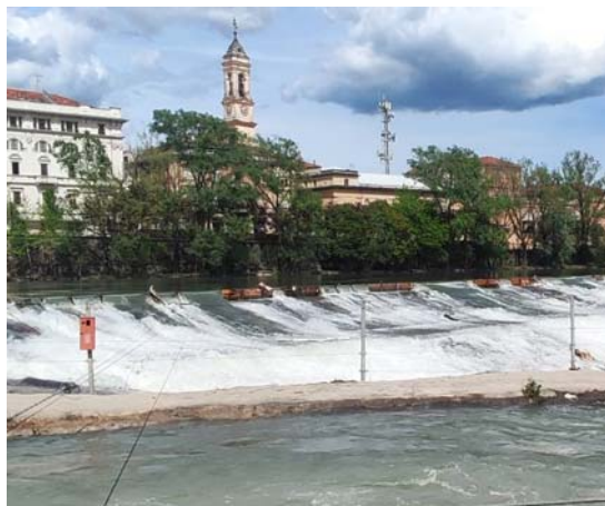
Naviglio d'Ivrea DA RIPRISTINARE
