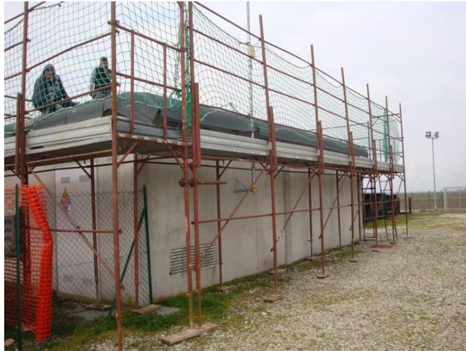
Lavori di impermeabilizzazione copertura locali tecnici
