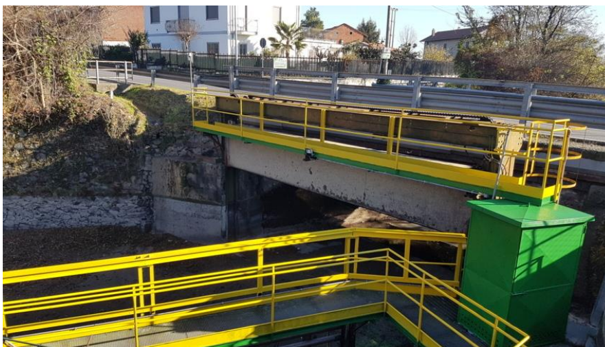
Situazione dopo l'intervento
