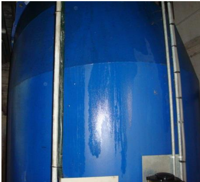
Colature di olio sul corpo turbina al piano interrato
