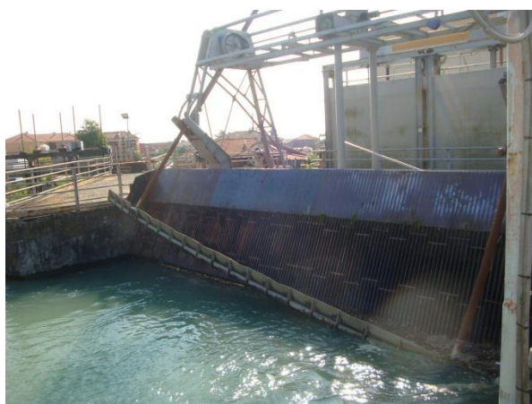
Sistema di sgrigliatura detriti
