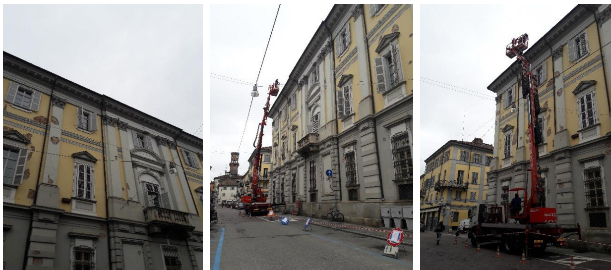
Sistemazione facciata via Gioberti Palazzo Pasta
