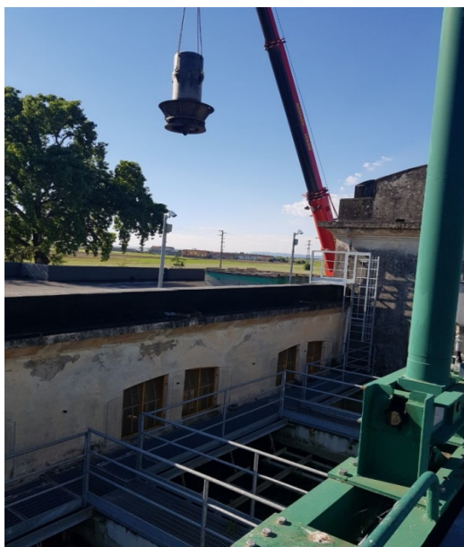
Operazione di rimozione gruppo
