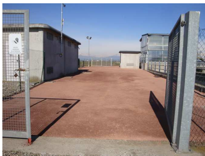
Nuovo piazzale centrale
