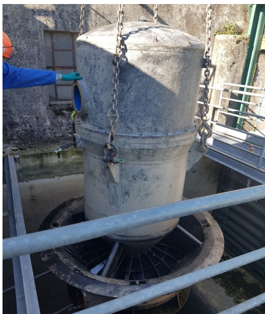
Operazione di rimozione gruppo
