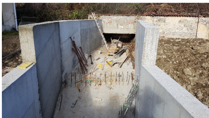
Edificio alloggiamento valvola by-pass e relativo canale
