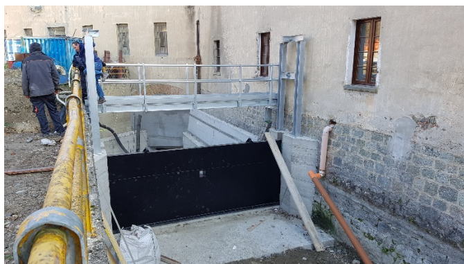
Posa pancone canale di scarico
