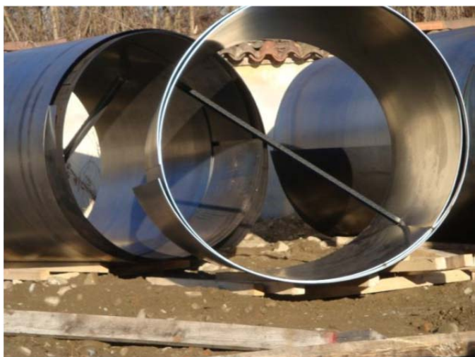
Posa calandra di rivestimento interno tubazione
